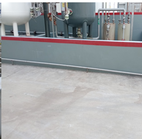
车间中转罐区围堰
