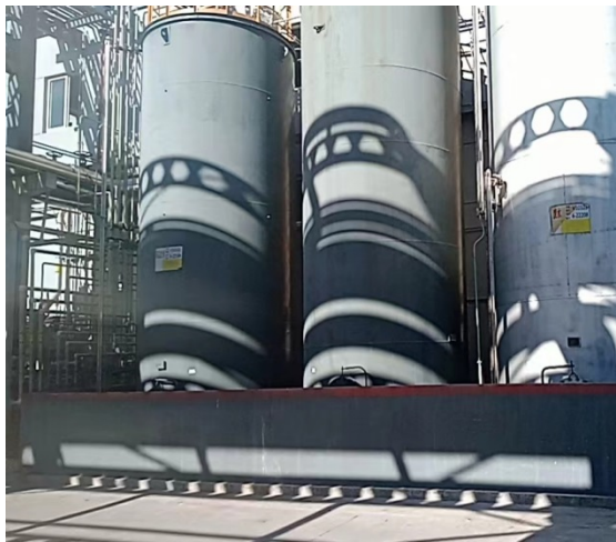
废水储罐区围堰
